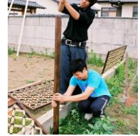
津波で流された塀の代りに木の柵を作っています。
